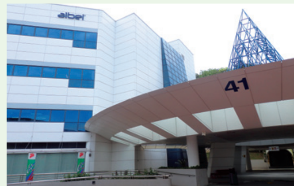
シンガポールアプリケーションセンター
